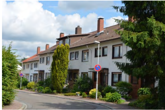
Abbildung 10: Zweigeschossige Reihenhäuser in Lerchenberg-Süd; Foto: IWU
