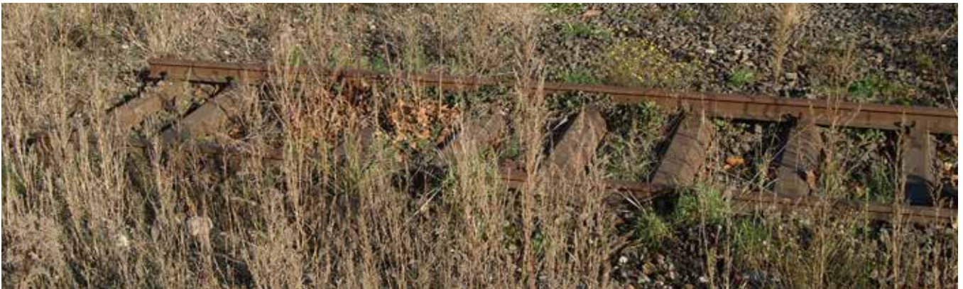
Die Deportationsrampe am ursprünglichen Standort vor dem Abbruch
