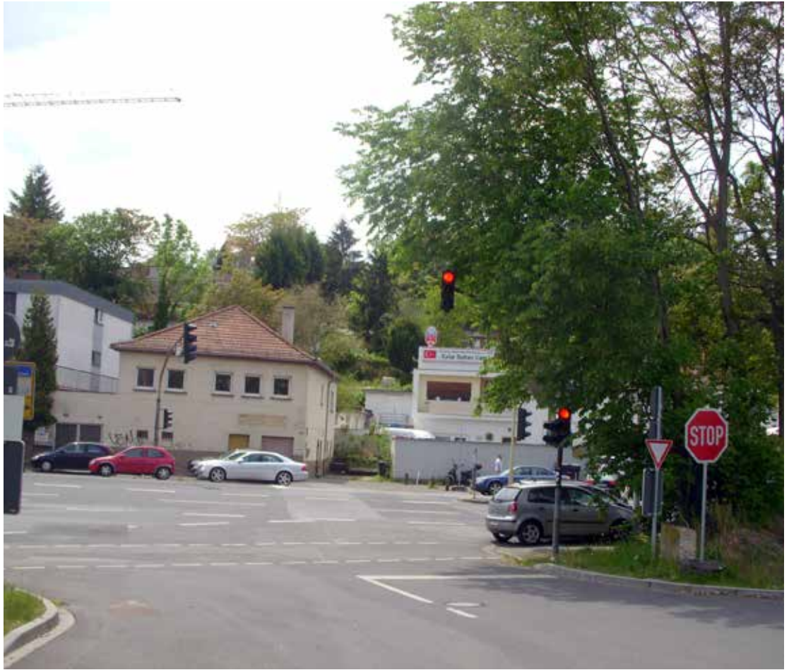
Ausfahrt östlich der Wettbewerbsfläche, Blick auf Mombacher Straße
