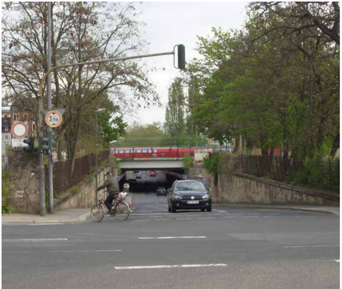
Goetheunterführung. Verbindung zwischen Neustadt/Hartenberg-Münchfeld
