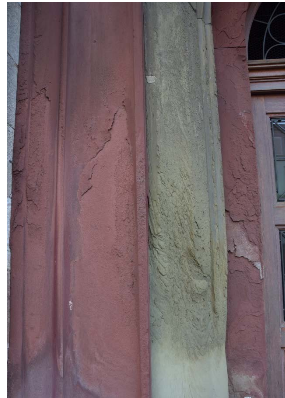
4 und 5: Der Sandstein am Portal sandet und blättert großflächig ab.
