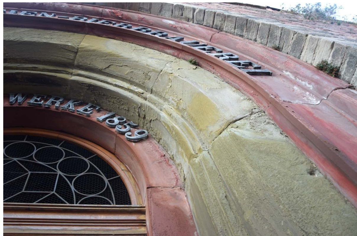
3: Verwitterte Sandsteinoberflächen und Abplatzungen im Rundbogen des Portals.
