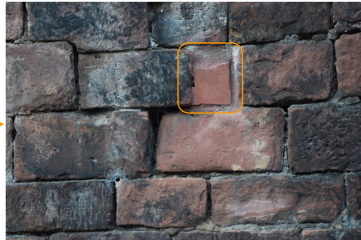
2: Detail: Ausgewaschene Fugen und eine Ziegelflickung.
