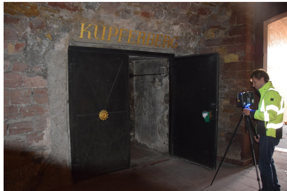
4: Zugang zum westlichen Gewölbekellerabschnitt.
