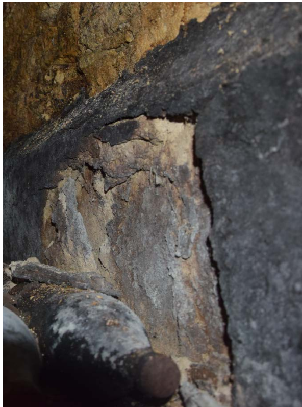
1: Franz Kupferberg - Lockerer Putz, sowie großflächige Putzabplatzungen.
