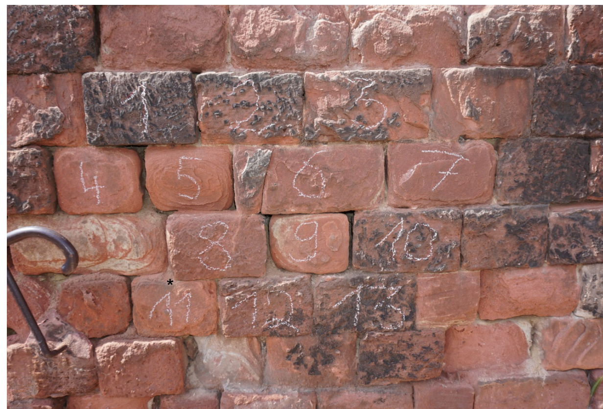
2: Sondierungsöffnung „Treppenpodest“, vor dem Öffnen.
