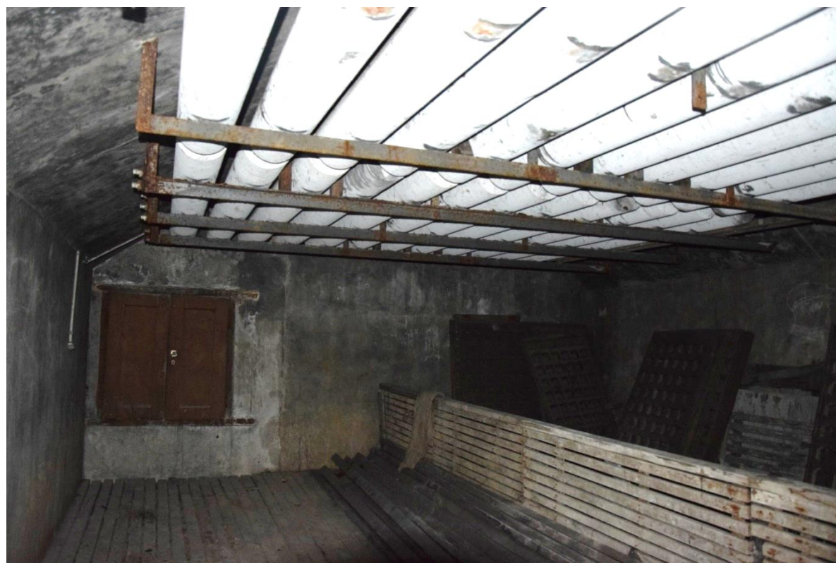
3: Ehem. Privatkeller/Lagerraum – obere Kellerebene, Blickrichtung Süd.
