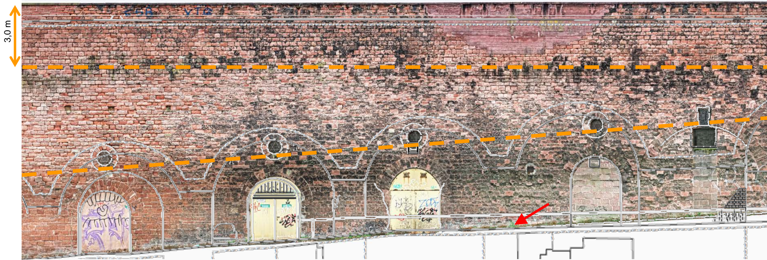
2: Überlagerung der Ansicht mit dem Längsschnitt. Zwischen den zwei gestrichelten Linien zeichnet sich ein „Salzstreifen“ ab. Die obere Begrenzung liegt etwa 3,0 Meter unterhalb der OK Brüstung, d.h. ca. 2,0 Meter unter OK Terrasse. Die untere Begrenzung liegt ca. auf Höhe der hinter der Stützwand liegenden Gewölbe.
