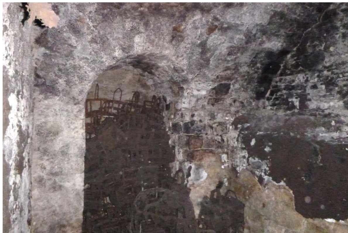
3: Schwer zugänglicher Abschnitt des „Franz Kupferberg“ Kellers.
