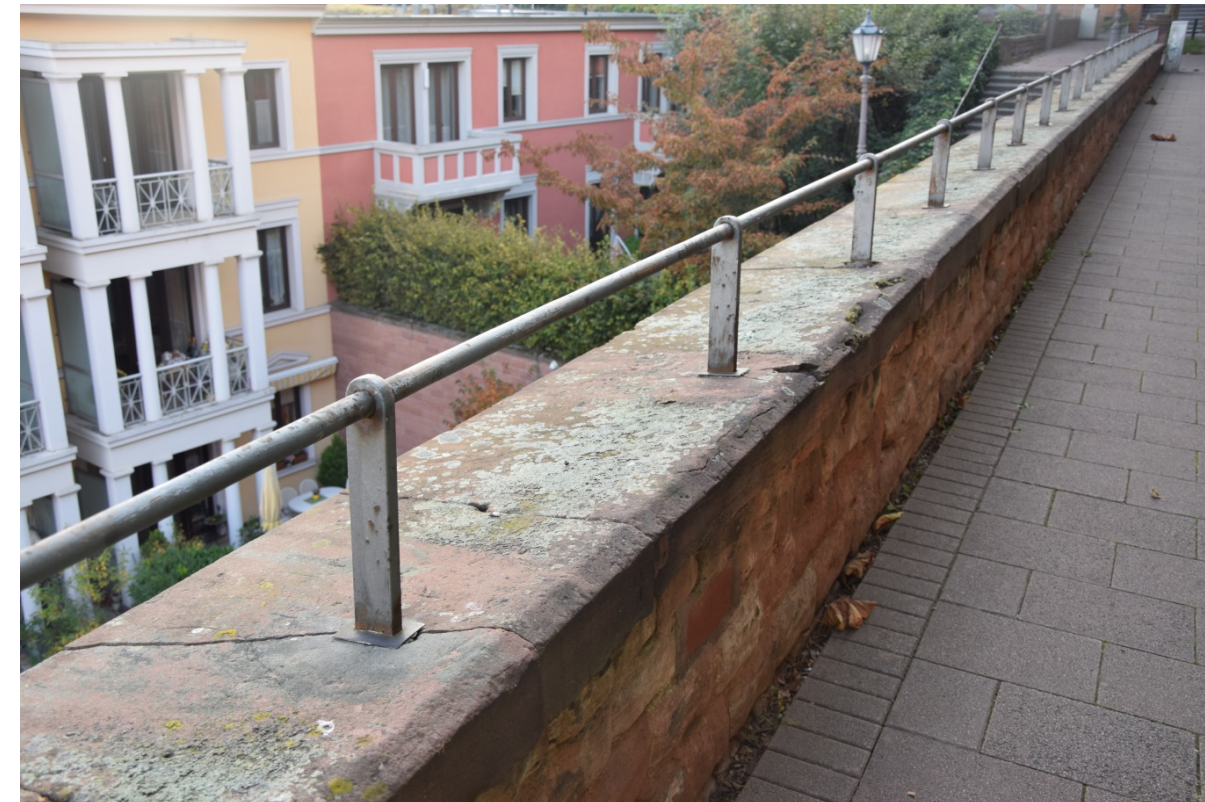
4: Obere Terrassenebene – Brüstung mit Absturzsicherung.
