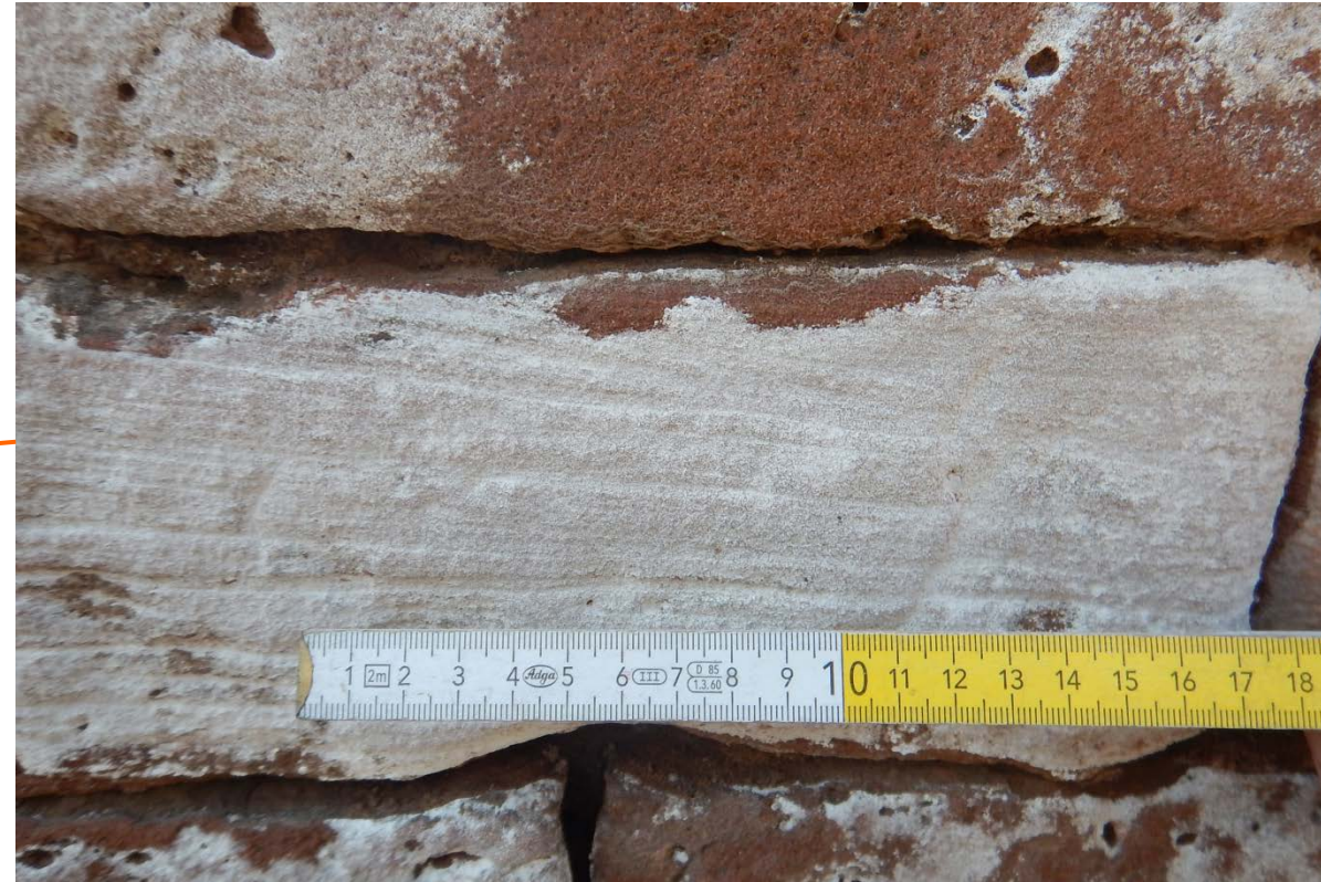
2: Die Steinoberfläche ist vollständig mit Salzkristallen bedeckt.
