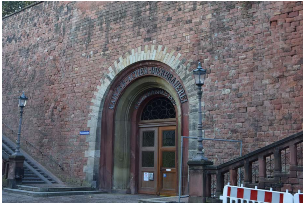
1: Blick auf den Portaleingang zum Oktogon und den seitlichen Treppenaufgängen zur oberen Terrassenanlage.
