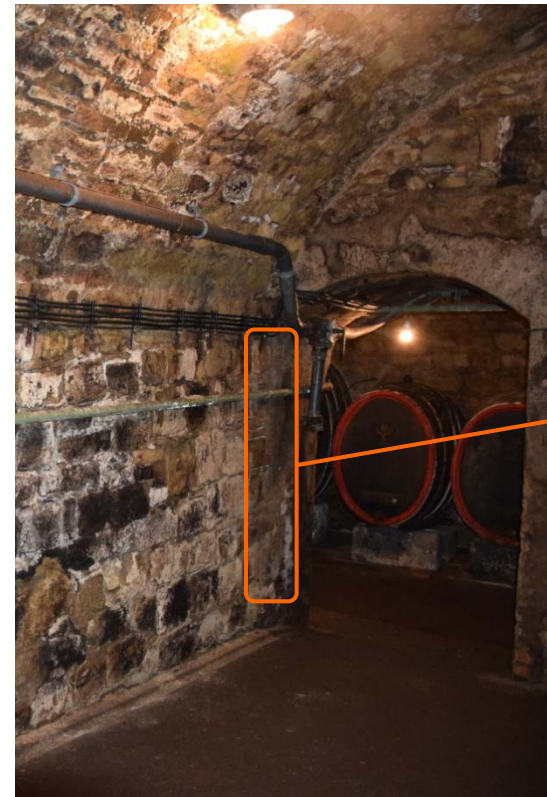
2 und 3: Ennius - Risse in Tüргewände
