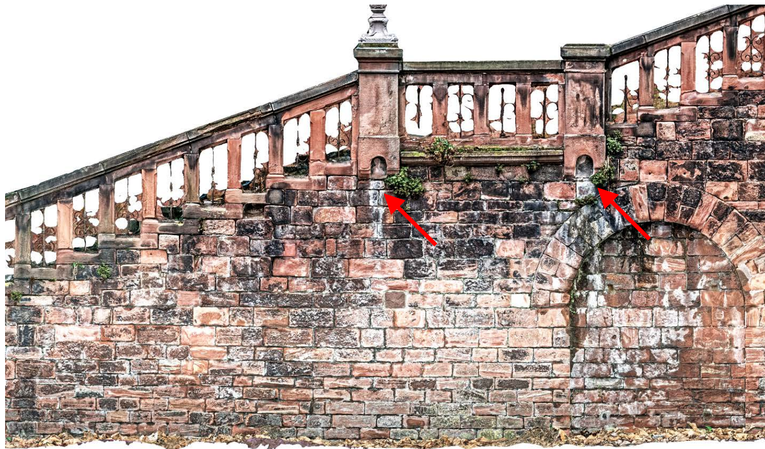
1: Auf der Mauerwerksoberfläche unterhalb der Treppen finden sich weiße Schlieren. Dabei handelt es sich um Salzausblühungen. Das Ausmaß ist in den niederschlaggeschützten Bereichen besonders ausgeprägt.
