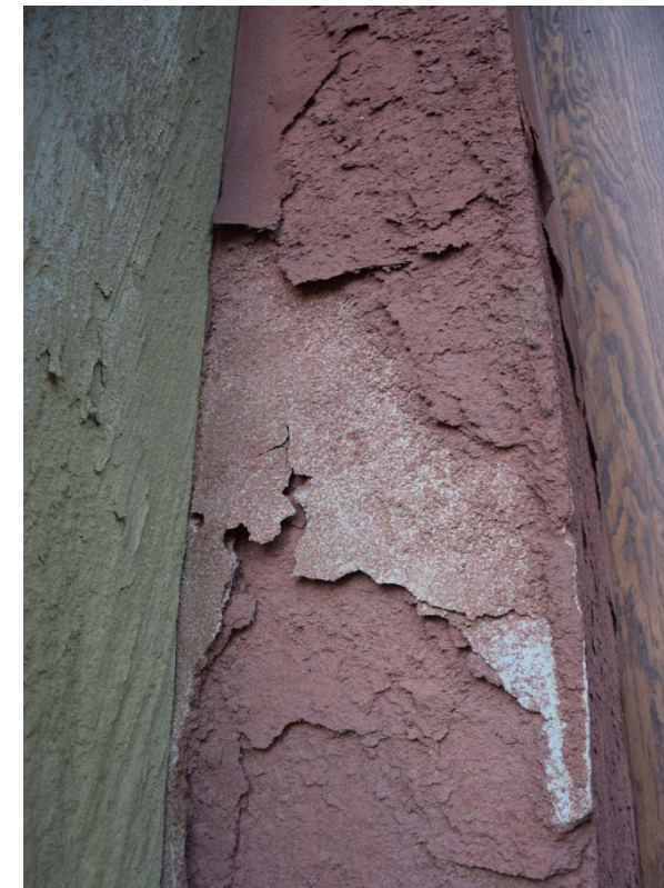
4 und 5: Der Sandstein am Portal sandet und blättert großflächig ab.
