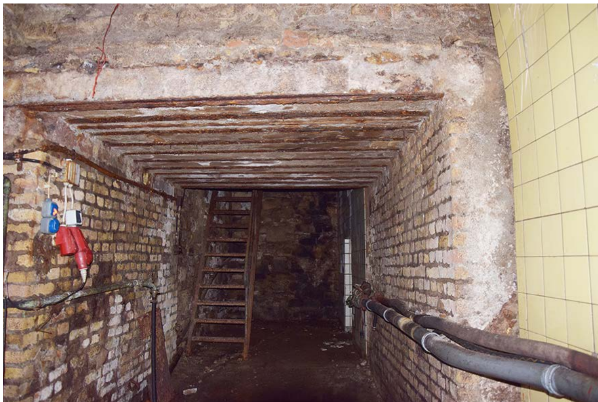
3: Untere Ebene, „Untertunnelung“ der Trennwand zwischen Tank 39 und 40.
