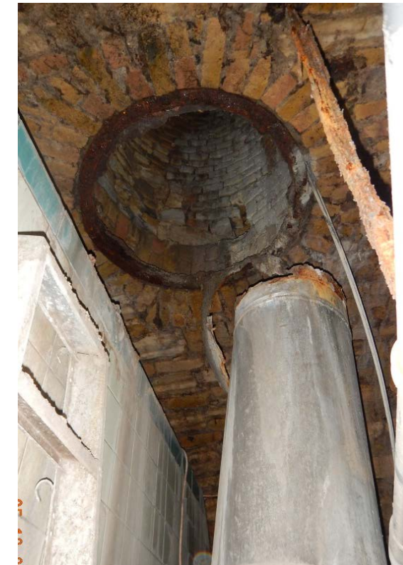
2: Untere Kellerebene - Überwölbter Zugang zu den Kellern „Main und „Donau“ (Bild links), sowie ein bis zum Straßenniveau reichender Kaminschlott.
