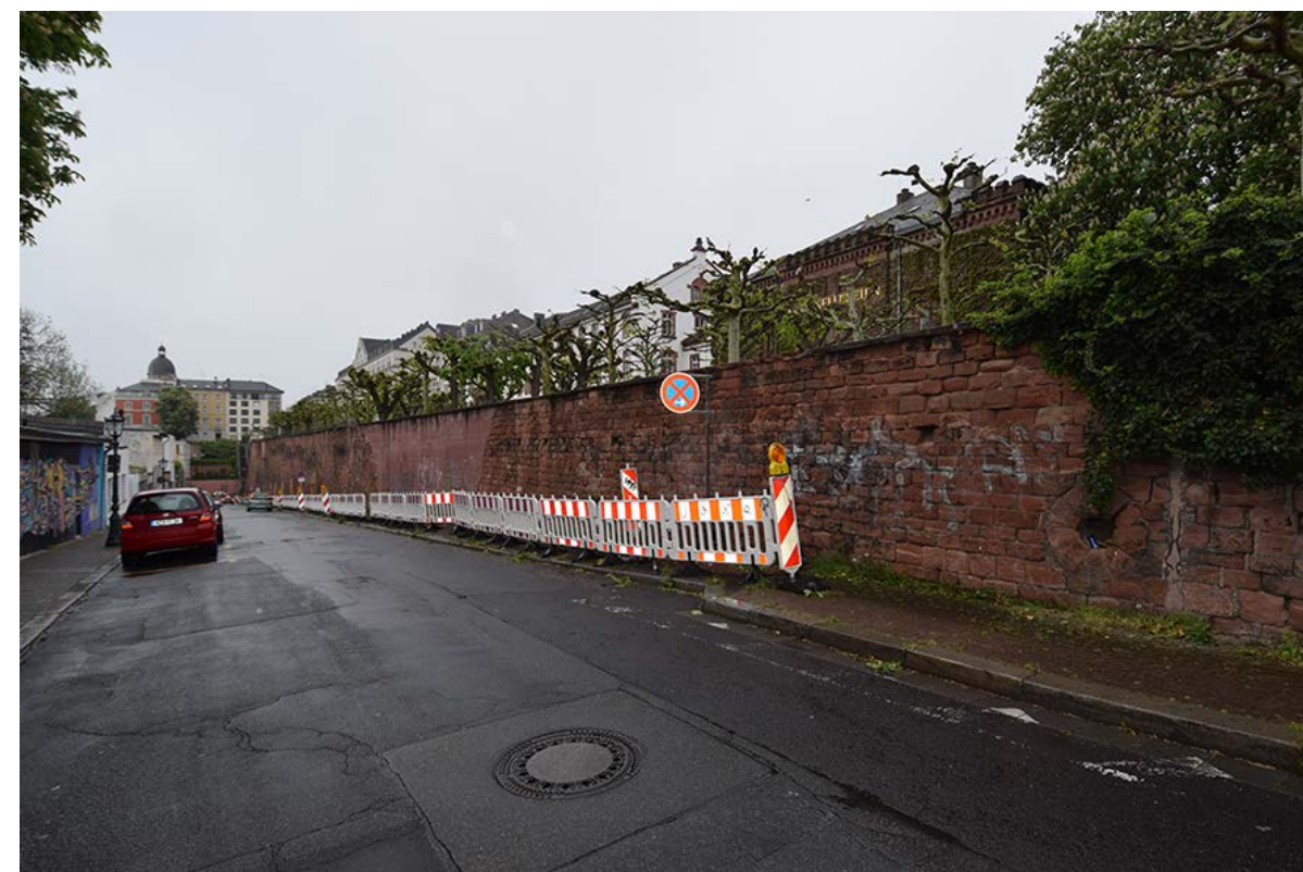
4: Blick nach Südosten entlang der Terrassenstraße. Die Höhe der Stützmauer nimmt bis zum Hauptportal stetig zu.
