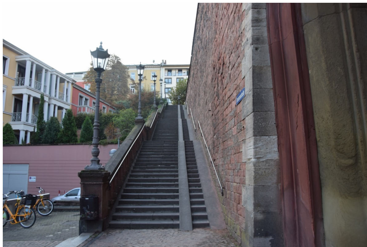
3: Blick nach Osten: Zweiläufige Treppe mit drei Podesten zur Erschließung der Oberen Terrassenebene.
