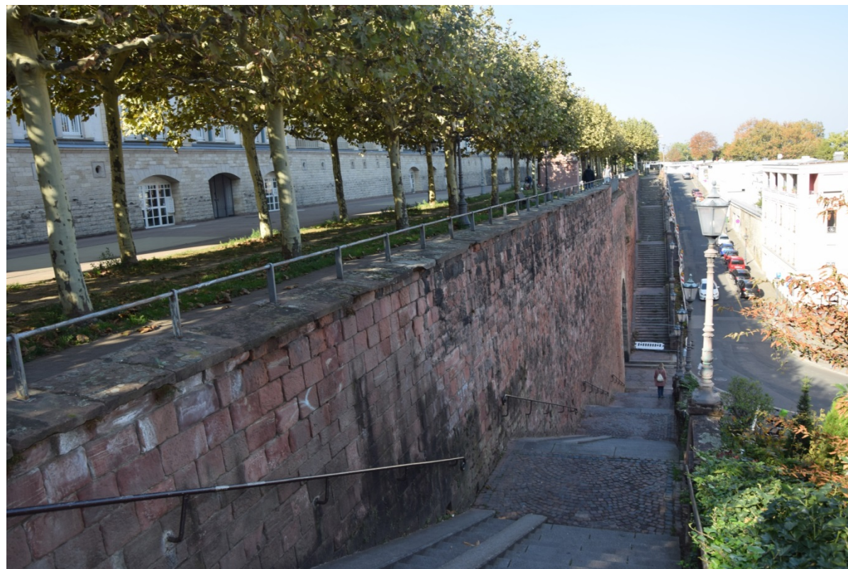
3: Blick nach Westen auf die Terrassenanlagen, unten die Terrassenstraße über die Kupferbergterrasse: Quadersteinmauerwerk aus Sandstein, Rundbogenportal als Zugang zum Oktogon und Sektkeller mit Tonnengewölbe unterhalb der Terrasse.
