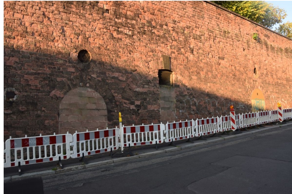
2: Zugemauerte Zugänge zu den Gewölbekellern.
