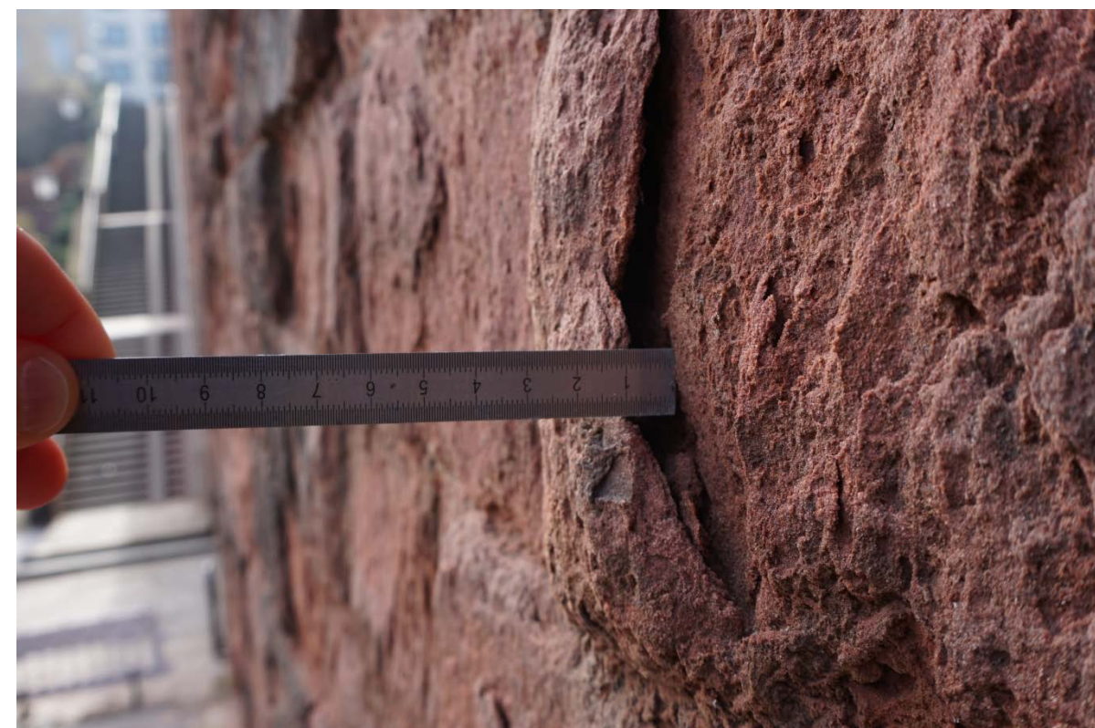
4: Die entfestigte Sandsteinoberfläche sandet ab.
