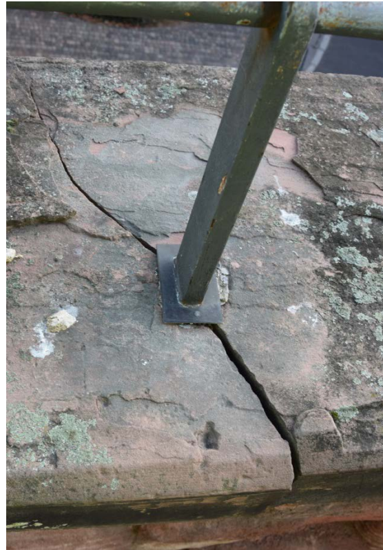
1: Mauerkrone Ostseite - angesprengte und lose Mauerkronenabdeckung.
