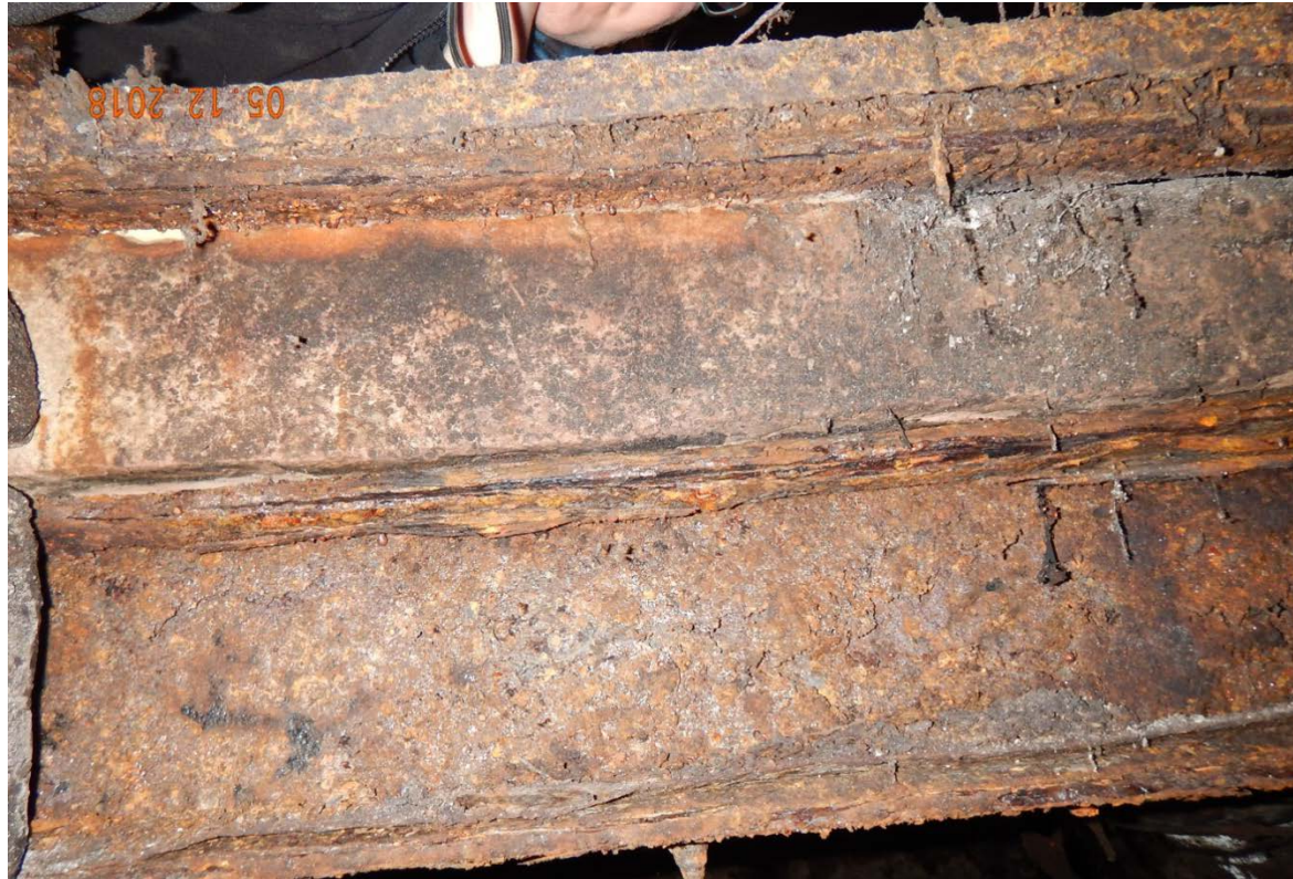
1: Korrodierte Eisenträger.
