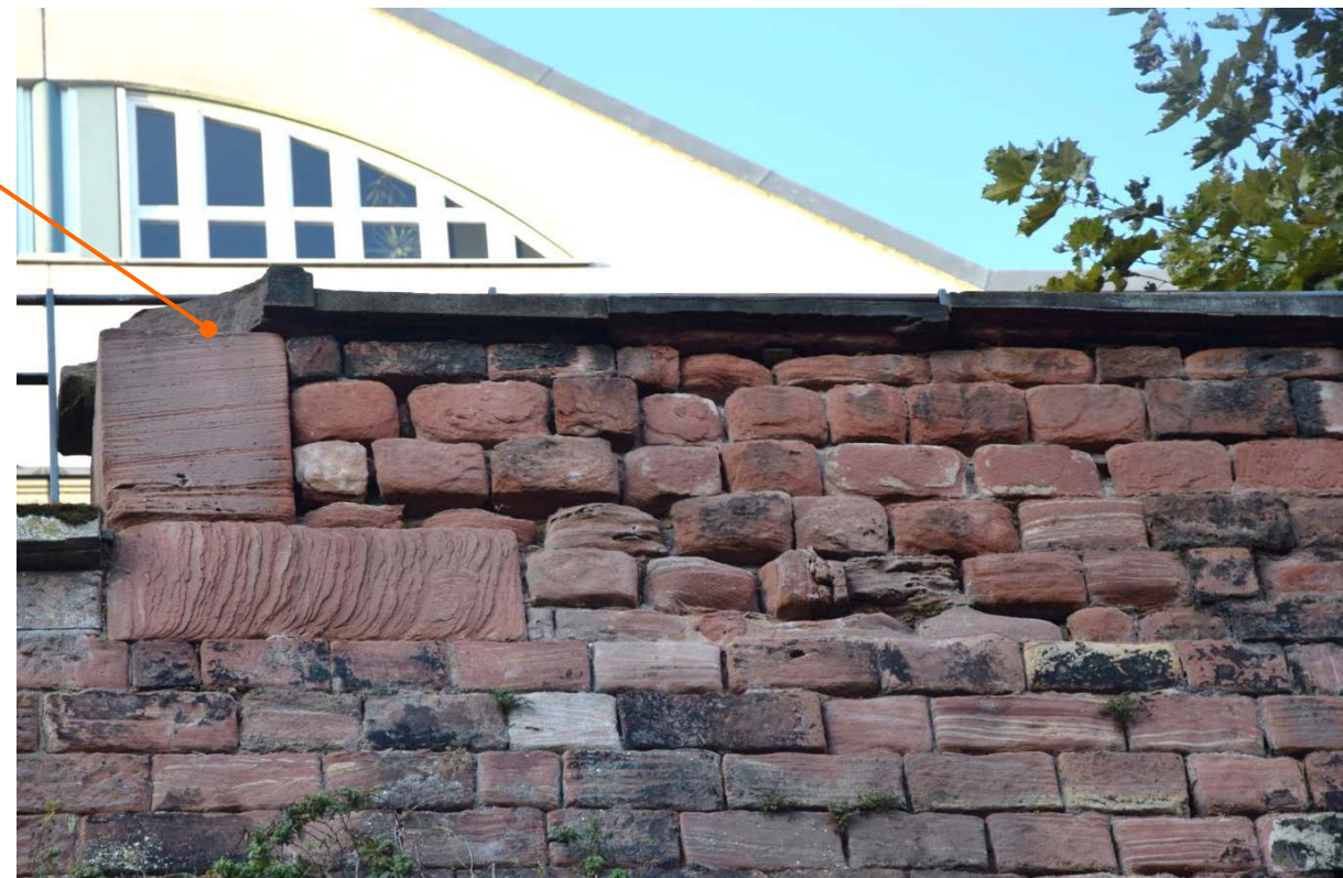
2: Ausgetauschte Mauersteine, Bewuchs, sowie stark ausgewitterte Fugen und verwitterte Steinoberflächen
