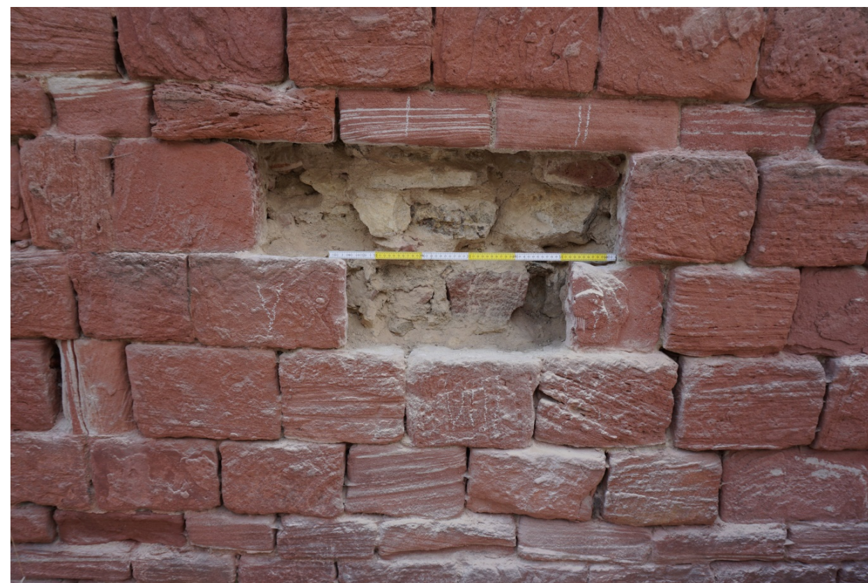
4: Sondierungsöffnung „Straße“, nach dem Öffnen.
