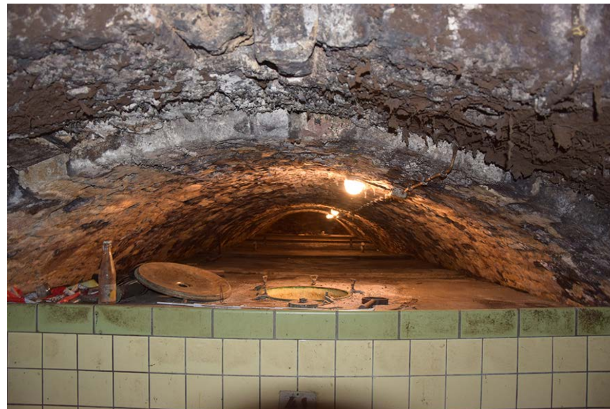
4: Blick in den Keller Antonius/Brutus mit Tank Nr. 41.
