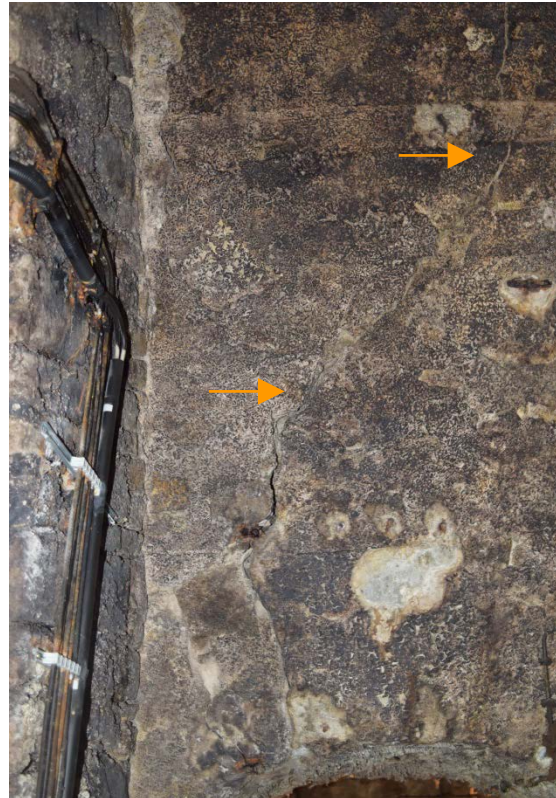
1 und 2: Durus-Caesar – in Längsrichtung verlaufender 1cm breiter und ca. 10 cm tiefer Riss im Durchgang zum Caesarkeller. Der Riss setzt sich dort entlang der Gewölbewange fort.
