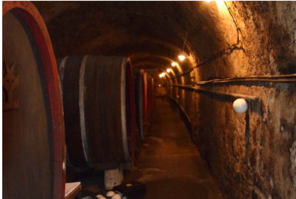
1: „Flavius“ Gewölbe: ca. 34 m langes und 3,5 m breites Tonnengewölbe aus Sandsteinquadern.
