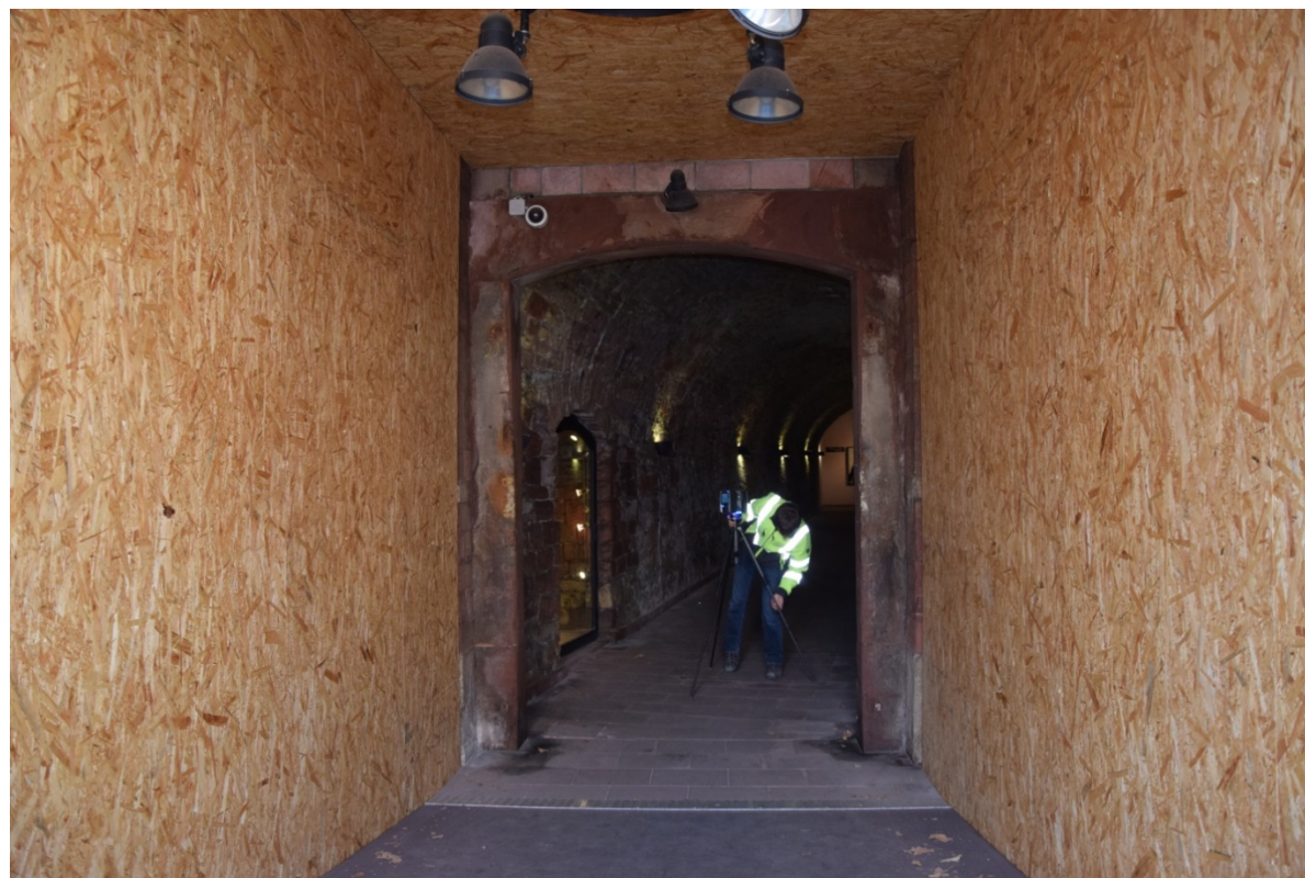
3: Oktogon mit Notsicherung (Stand 11.10.2018).
