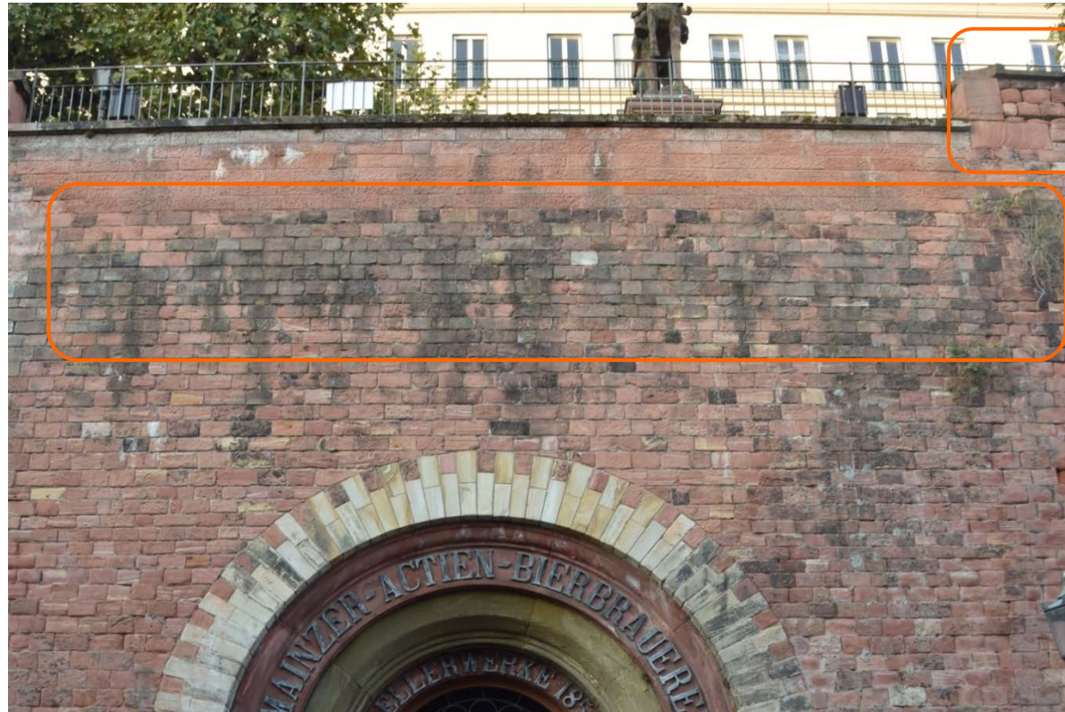
1: Algen- und Moosbewuchs auf der sanierten Mauerfläche (1975)
