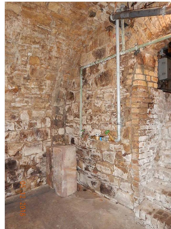
4: Stirnseite „Ennius“ mit vertikaler Baufuge
