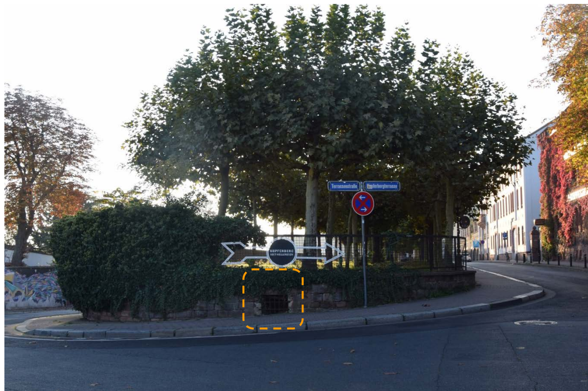
3: Lüftungsschacht am westlichen Ende des Kellerkomplexes.
