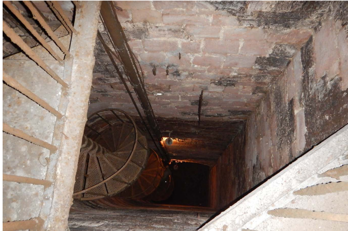
1: Wendeltreppe zu den ca.11,9m tiefer gelegenen Kellern „Main“ und „Donau“
