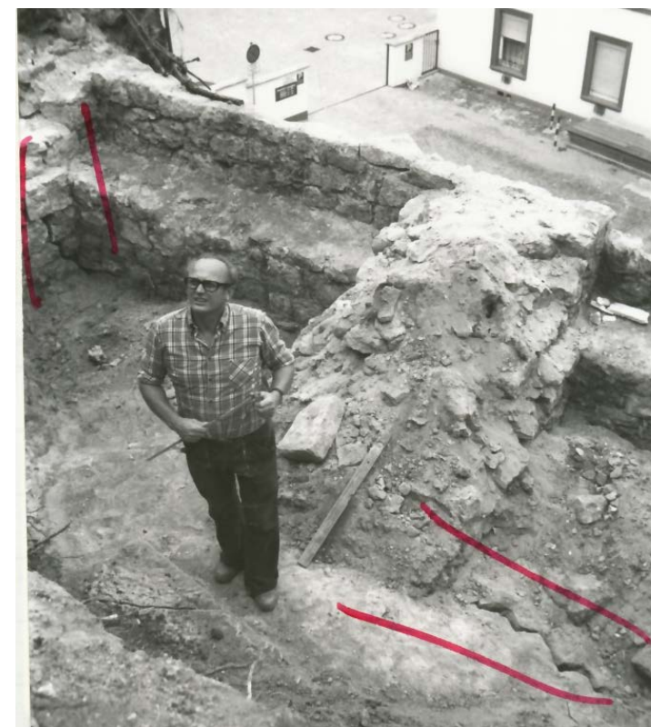
4: Foto aus der Baudokumentation von 1975 Bei der Freilegung der Oktogonkuppel wurden Risse in der Kuppel und im angrenzenden Mauerwerk sichtbar. Hier wurden damals deshalb ein Ringbalken und eine Betonplatte eingezogen.
