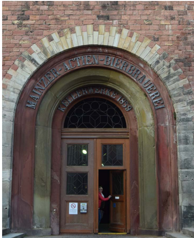
1: Rundbogenportal mit zweiflügliger Holztür; Hauptzugang und Eingang in die Oktogonhalle
