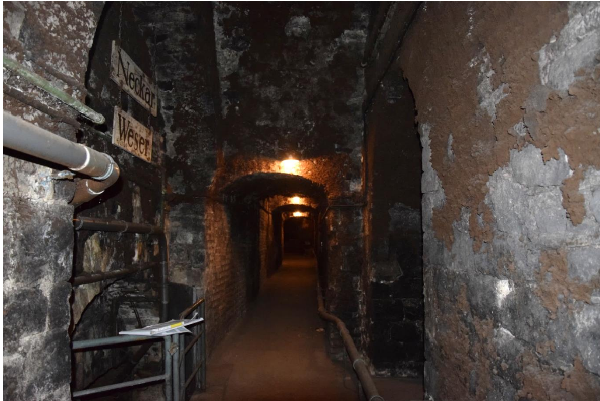
1: Blick nach Westen entlang des Erschließungsgangs an der äußeren Stützmauer.
