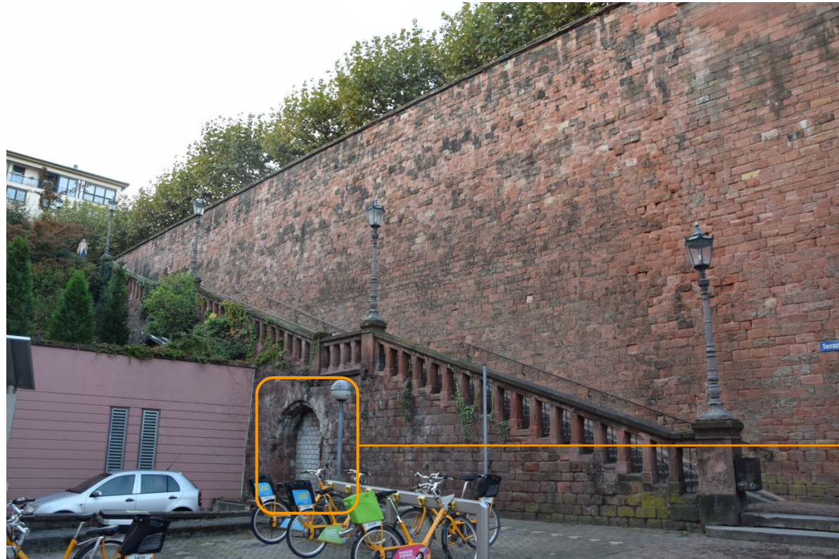
1: Blick auf den linken östlichen Treppenaufgang.
