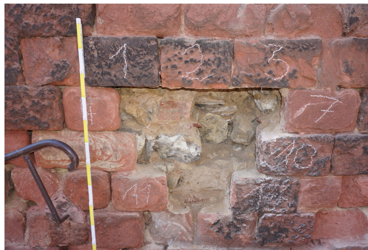
4: Sondierungsöffnungen „Treppenpodest“, nach dem Öffnen.
