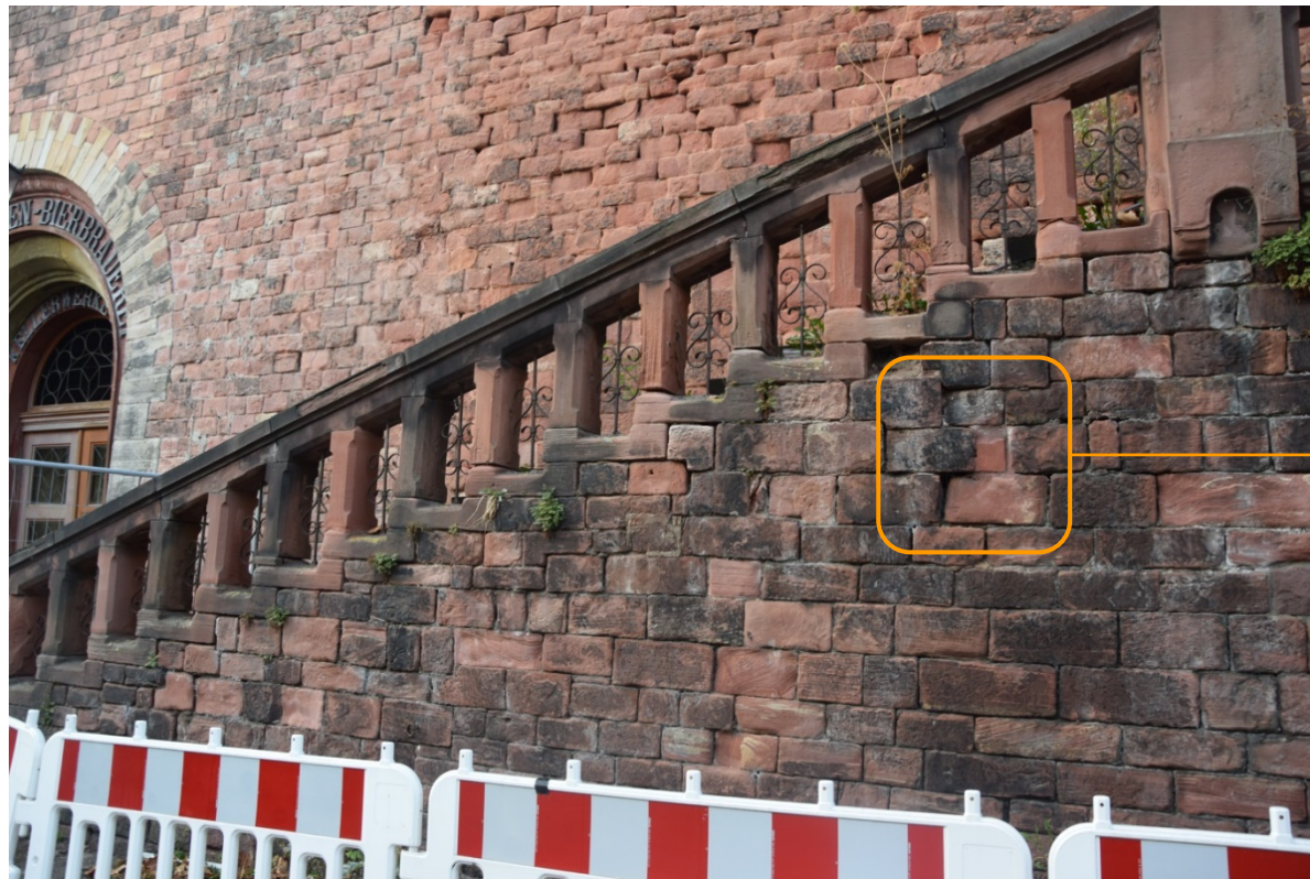
1: Verwitterte Steinoberflächen, Bewuchs, Ausbrüche und Ziegelflickung.
