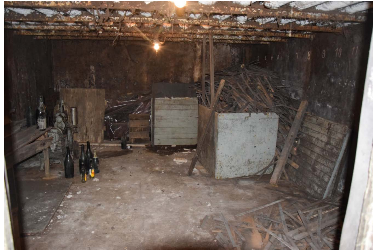
2: Ehem. Privatkeller/Lagerraum – Blickrichtung Nord
