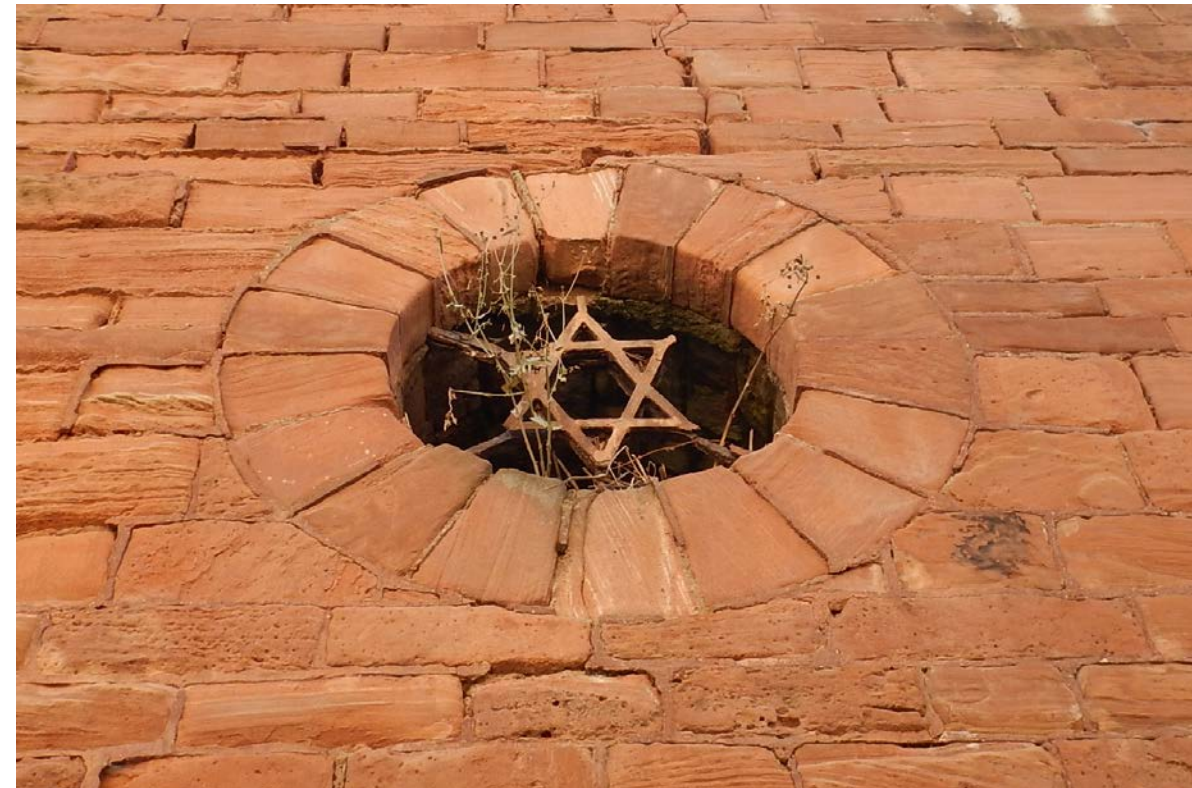
3: Gemauertes Rundfenster mit den Resten einer sternförmigen Vergitterung – Hexagramm als Brauerzeichen; nur bei den Kellern der Actienbrauerei.
