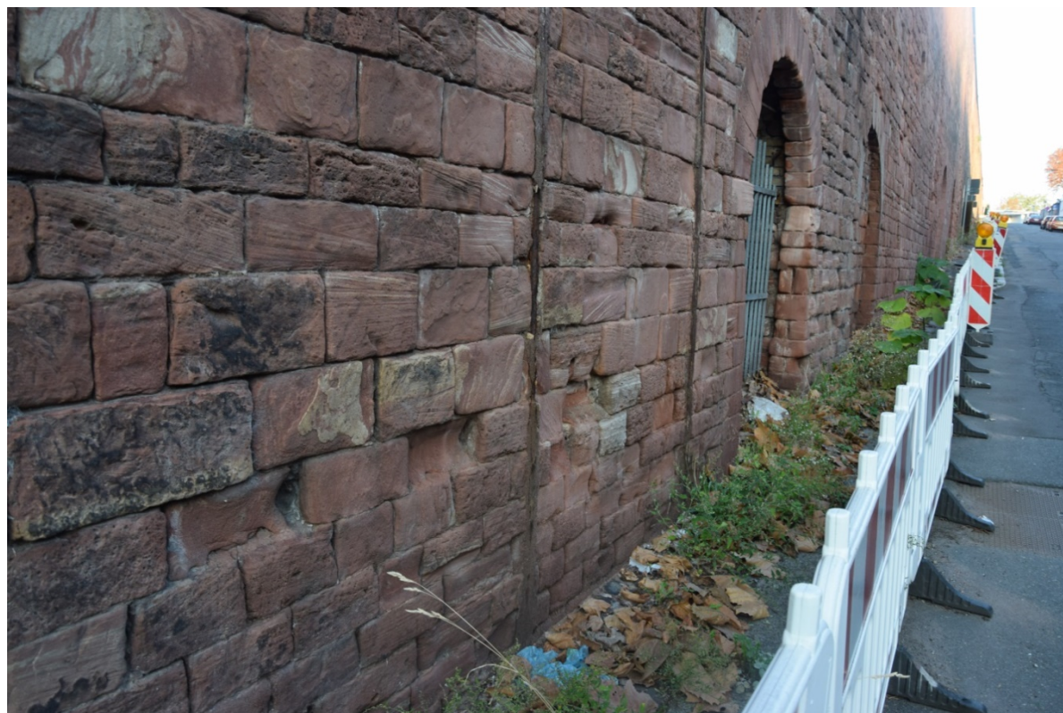
3: Ausgewaschene Fugen und teils stark zurückgewitterte Sandsteinoberflächen
