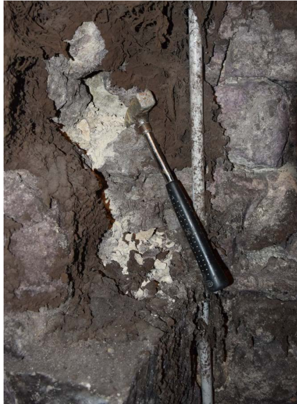
1 und 2: Brüchiger Fugenmörtel und lockerer Mauerstein.
