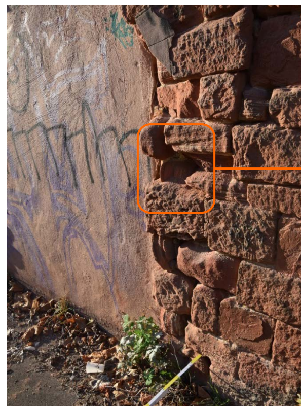
4 und 5: Starke verwittertes Mauerwerk mit Ausbrüche und tief ausgewaschenem Fugenmörtel.
