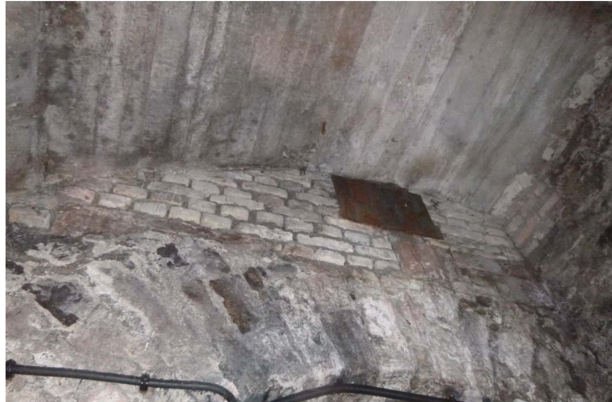
2: Treppenaufgang – Gewölbedecke aus Beton, sowie ein neu aufgemauerter Bereich im Gewölbeschild.
