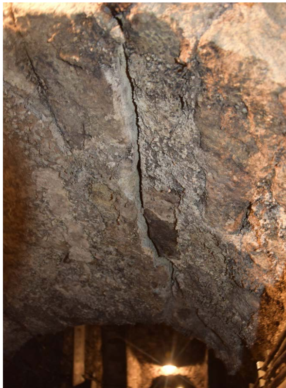
1 und 2: Durus-Caesar – in Längsrichtung verlaufender 1cm breiter und ca. 10 cm tiefer Riss im Durchgang zum Caesarkeller. Der Riss setzt sich dort entlang der Gewölbewange fort.
