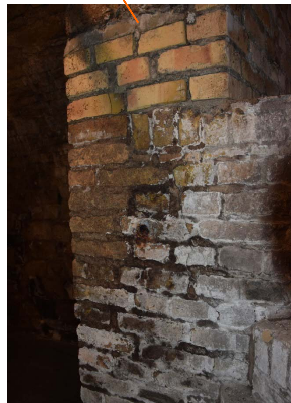
4 und 5: Ennius - Bis zu 8 mm breiter Riss erstreckt sich über die gesamte Gewölbebreite.
