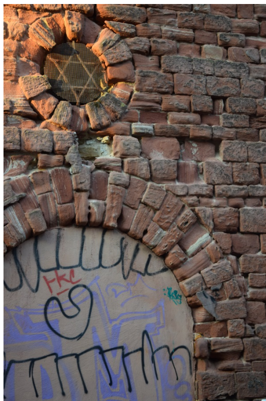
4 und 5: Starke verwittertes Mauerwerk mit Ausbrüche und tief ausgewaschenem Fugenmörtel.
