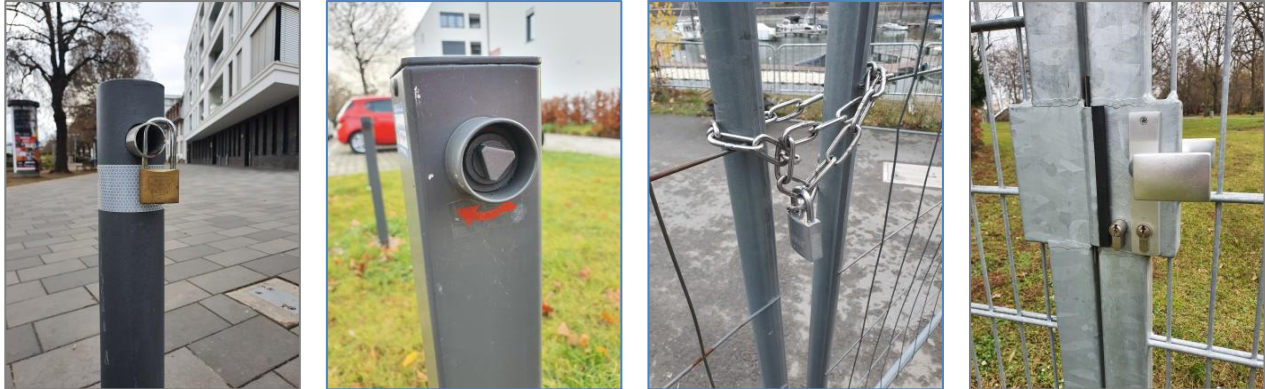
Bild 05: Sperrvorrichtungen (Vorhängeschloss, Dreikantschloss, Kette, FW-Schließung)
